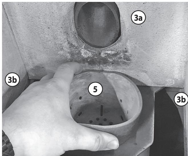
Retirez ensuite les **panneaux latéraux de gauche et de droite de l'habillage de la chambre de combustion (3b)**. Chacun de ces panneaux est maintenu sur le bas par une **tôle de sécurité**.
