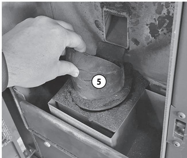
Après un nettoyage minutieux, il ne doit plus rester de résidus de cendres dans le pot brûleur. Les résidus brûlés et incrustés doivent être également éliminés le mieux possible. Les trous du pot brûleur ne doivent pas être obturés ou bouchés.
